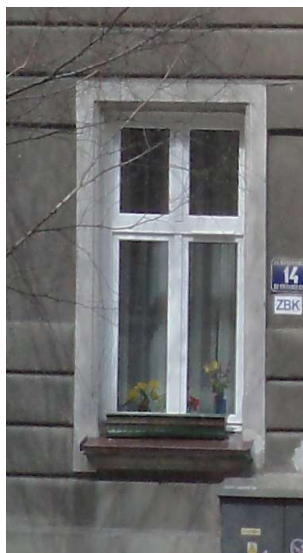
Fot. 2. Wymienione okno (B) z gładkim ślemieniem, w technologii PCV.
