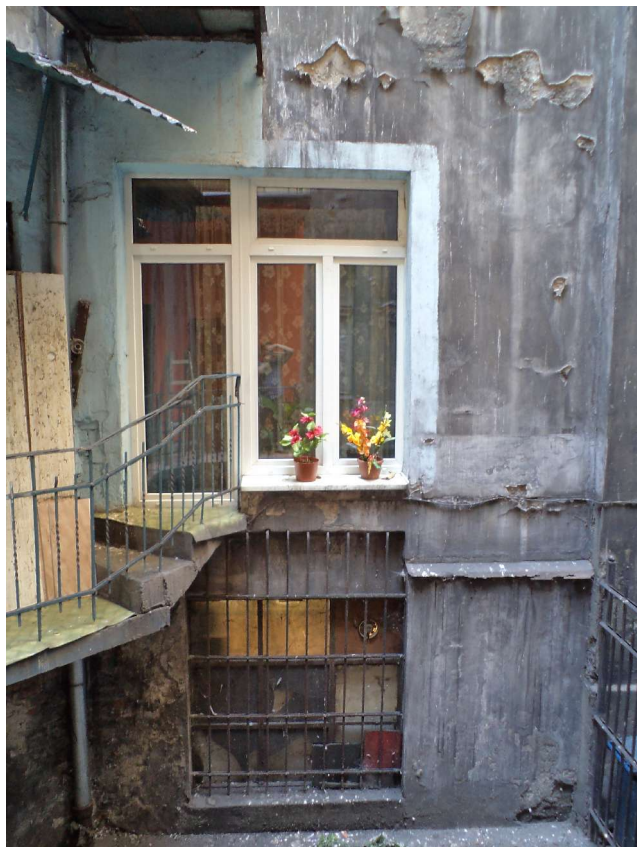
Fot. 18 Powiększony otwór okienny o drzwi balkonowe. Okno elewacji podwórzowej ściany zachodniej (V). Pod nim otwór okienny w cokole (U).
