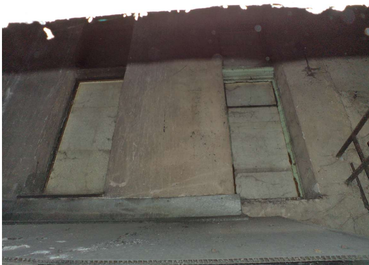
Fot. 23 Elewacja podwórzowa z wyślepionymi otworami okiennymi (okna sanitariatów ) -(Ł).
